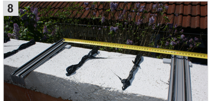
8 Adheseal (Streichbare Klebedichtmasse) mit Plastic Nozzle V-Form 8 x 8 (Kartuschen-Spitzen) und einem Kleberauppenabstand von 20 cm zwischen den Niederhaltern auf den Untergrund auftragen.
