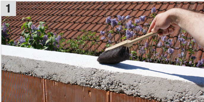
1 Den Untergrund staubfrei machen... (Wichtig: Der Untergrund darf nicht porös sein - ggf. mit grober Bürste und/oder Hochdruckreiniger poröse Teile des Betons entfernen)
