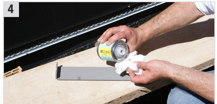
4 Seal Guard (Transparenter Primer) mit Hilfe eines Multi Wipes (Universaltuch) auf Niederhalter Rillenprofile dünn auftragen und mind. 15 Min. ablüften lassen (max. 4 Std.).
