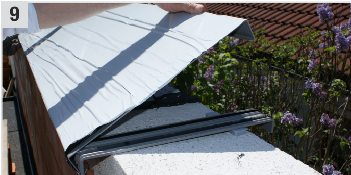
9 Alu-Fensterbank bzw. Mauerabdeckung innerhalb von 8 Min. (inkl. einrichten) montieren. Durch beschweren, die Teile 24 Std. gegen Wind- und Soglasten schützen.
