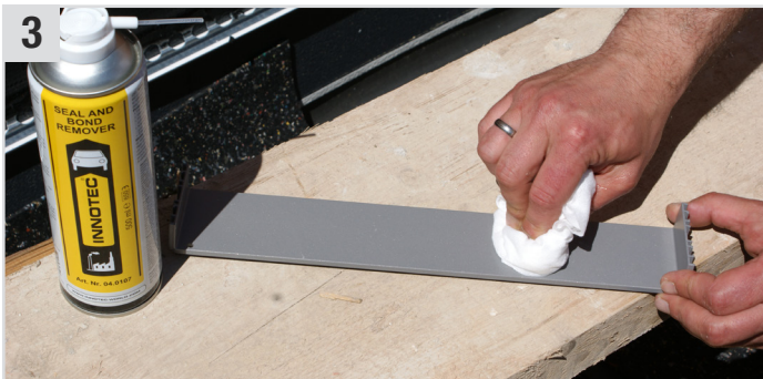
3 Niederhalter Rillenprofile mit Seal and Bond Remover (Klebstoff- & Dichtmassenentferner) und Multi Wipes (Universaltuch) entfetten (mind. 5 Min. ablüften lassen).
