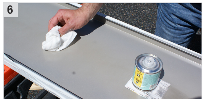
6 Seal Guard (Transparenter Primer) mit Hilfe eines Multi Wipes (Universaltuch) auf Fensterbank bzw. Mauerabdeckung dünn auftragen und mind. 15 Min. ablüften lassen (max. 4 Std.).
