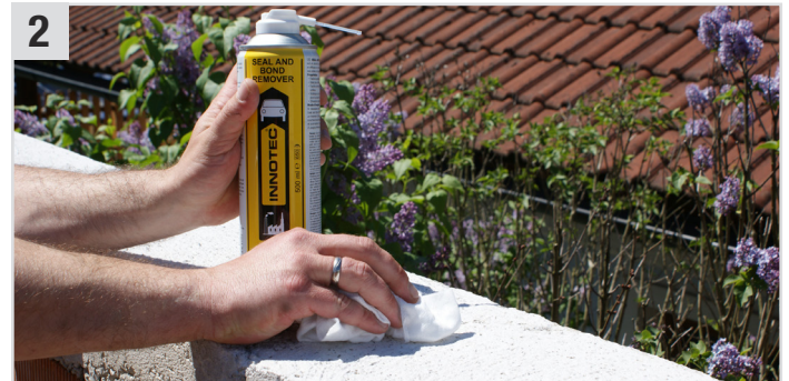
2 ... und anschließend mit Seal and Bond Remover (Klebstoff- & Dichtmassenentferner) und Multi Wipes (Universaltuch) entfetten (mind. 5 Min. ablüften lassen).
