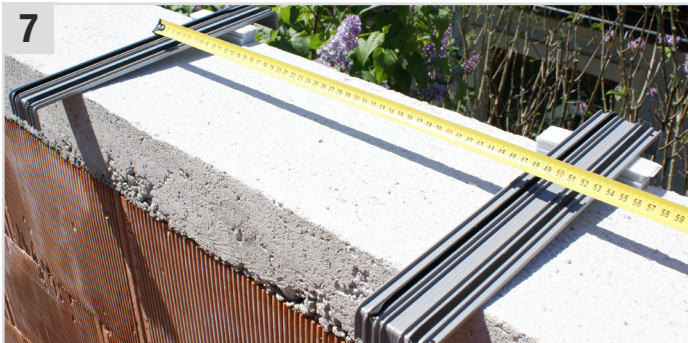
7 Niederhalter mit Adheseal (Streichbare Klebedichtmasse) im Abstand von 50 cm und innerhalb von 8 Min. (inkl. einrichten) auf den Untergrund kleben und 24 Std. trocknen lassen.
